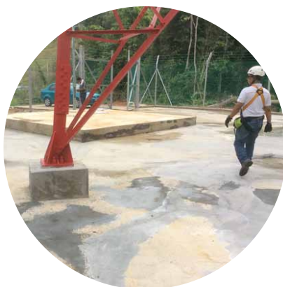
Aktiviti UAT sedang dijalankan di sekitar menara telekomunikasi.
