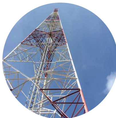
Menara telekomunikasi yang telah siap dibina di Kg. Mahawangsa, Kedah.
