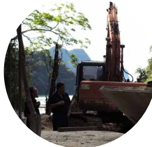
Pembinaan salah sebuah menara telekomunikasi di Pulau Dayang Bunting.
